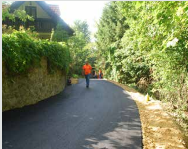
Asfaltiranje ceste v Poljanski gori
